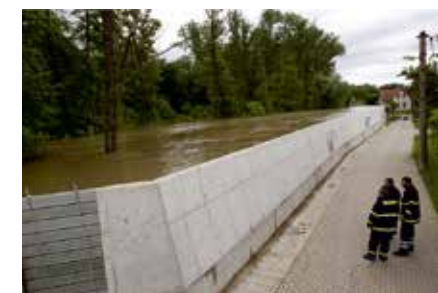
STRUKTURÁLNÍ PROTIPOVODŇOVÁ OPATŘENÍ PEVNÉ VALY A ZDI
