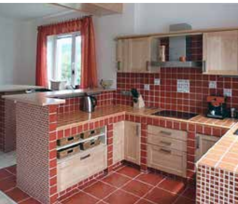
Odolnou kuchyňskou linku lze řešit pomocí betonové desky na pilířích s omyvatelným povrchem. Dvířka a vybavení by měly být snadno demontovatelné.
