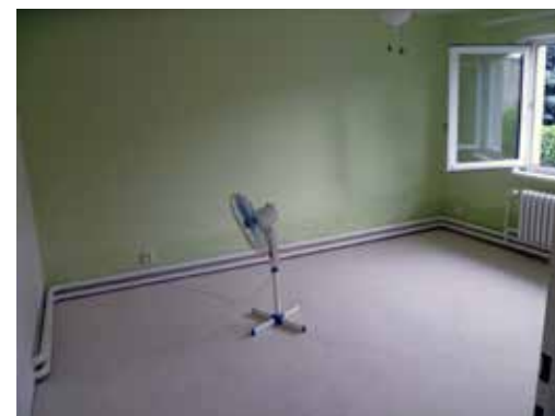
V případě pasivního vysoušení zajistěte dostatečné proudění vzduchu, vytvořte průvan.
