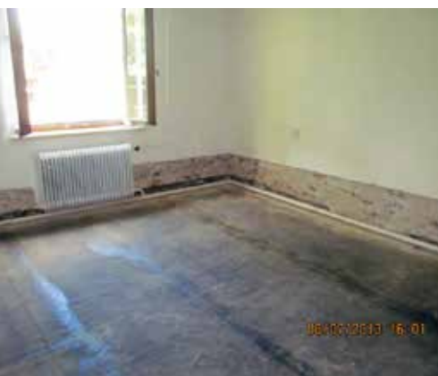
Odstraňte zničené podlahy a pruh omítky u podlahy pro rychlejší vysychání stavby.
