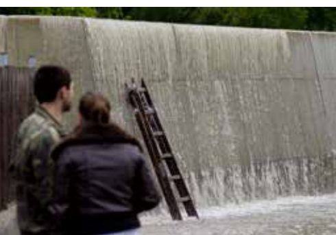
Protipovodňové zdi a valy neposkytují stoprocentní ochranu. Zeď v Hoříně, když přetekla za povodní v roce 2013.
