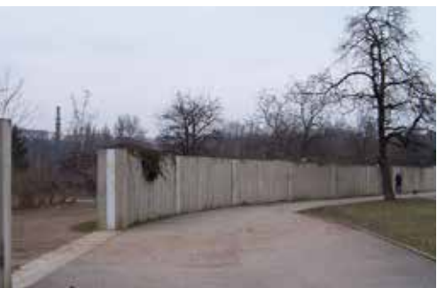
Protipovodňové zdi jsou mnohdy terčem kritiky obyvatel měst, že jsou nehezké. Libeňský ostrov. Stezka podél protipovodňové zdi.
