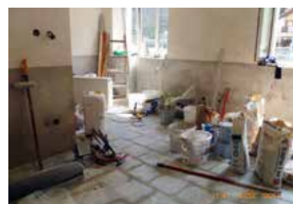
OPRAVY A OBNOVA
