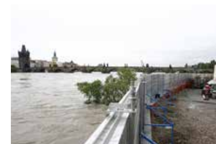
STRUKTURÁLNÍ PROTIPOVODŇOVÁ OPATŘENÍ MOBILNÍ HRAZENÍ
