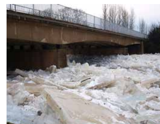
Ledová dřevnice se může zachytit na překážkách a způsobit povodeň. Led na řece Ayr.
