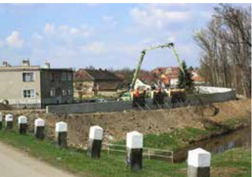
Ochranné hráze a zdi jsou finančně náročné liniové stavby, které se používají většinou při ochraně měst. Výstavba hráze v Hoříně.
